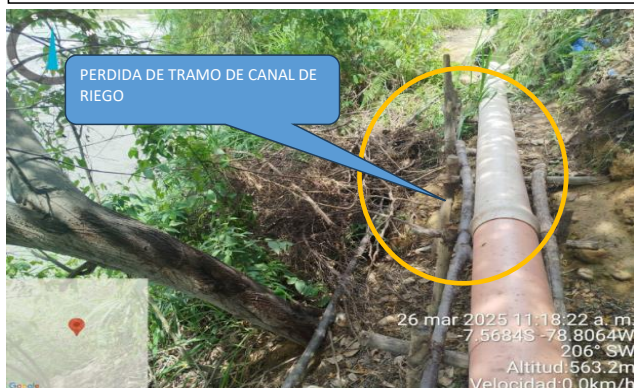
FOTOGRAFIA N° 7 Y 8 . EN LA TEMPORADA DE MAXIMAS AVENIDAS EL RIO CHICAMA, AH AFECTADO GRAN PARTE DE LA PLATAFORMA DE LA VIA TERRESTRE TRUJILLO - CASCAS , ADEMAS DE LA PERDIDA DEL UN TRAMO DE CANAL DE RIEGO CUYOS TRAMOS SE ENCUENTRA DESPROTEGIDO A DESLIZAMIENTO Y EROSIONES OCASIONADAS POR EL RIO CHICAMA EN EL CASERIO
