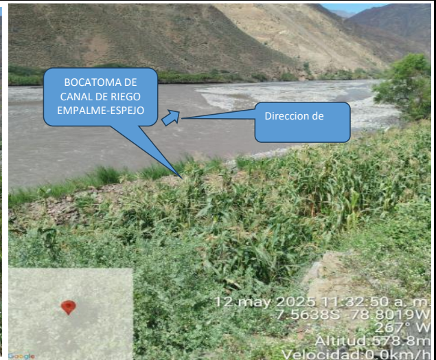
FOTOGRAFIA N° 1 Y 2 . TRAMO CRITICO EN EL RIO CHICAMA , EN LA TEMPORADA DE MAXIMAS AVENIDAS HACE DESASTRE Y DAÑOS A LA BOCATOMA DEL CANAL DE RIEGO EL EMPALME - ESPEJO , TERRENOS DE CULTIVOS Y CONSTRUCCIONES ALEDAÑAS AL RIO CHICAMA EN EL CASERIO COJITAMBO AGUAS ABAJO, VULNERABLE A LAS VELOCIDADES EROSIVAS DEL RIO
